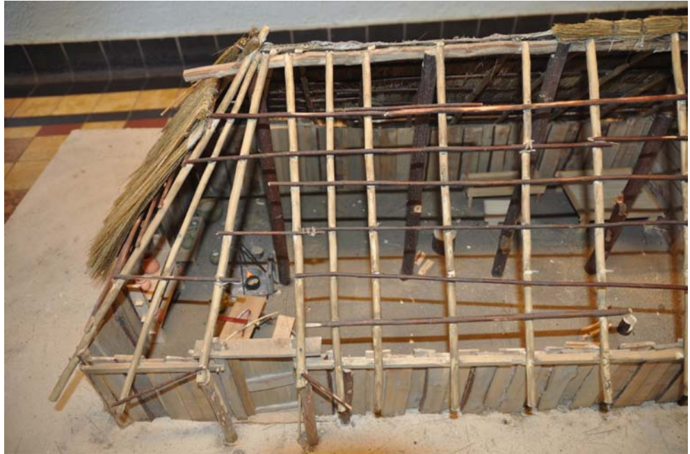
Afb. 15.25. Inkijkje vanuit het opengewerkte dak in het woongedeelte.
