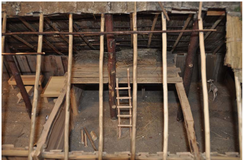
Afb. 15.26. Inkijkje vanuit het opengewerkte dak in het stalgedeelte. Vanwege een enkele extra buitenpaal is er voor gekozen een liggende balk te plaatsen met daarop een verhoogde vloer. Dergelijke verhogingen waren bij uitstek geschikt om allerlei zaken droog op te slaan.
