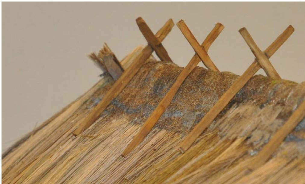
Afb. 15.20. Dakruiters, gekruisde balkjes werden op de nok gelegd om de plaggen op zijn plaats te houden. De uiteinden werden vermoedelijk door het riet heen met de daksporen verbonden. Zo ontstond er een stevige constructie.
